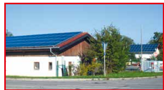
Fotovoltaik-Anlage auf dem Dach des Wertstoffhofes Durach
