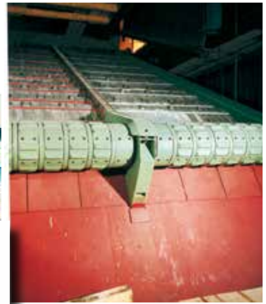
Der Ofenrost des neuen Kompaktofens: 8,5 Tonnen Brenngut bewältigt der „heiße Ofen“ pro Stunde. Die Verbrennungstemperatur beträgt dabei mindestens 850° Celsius.
