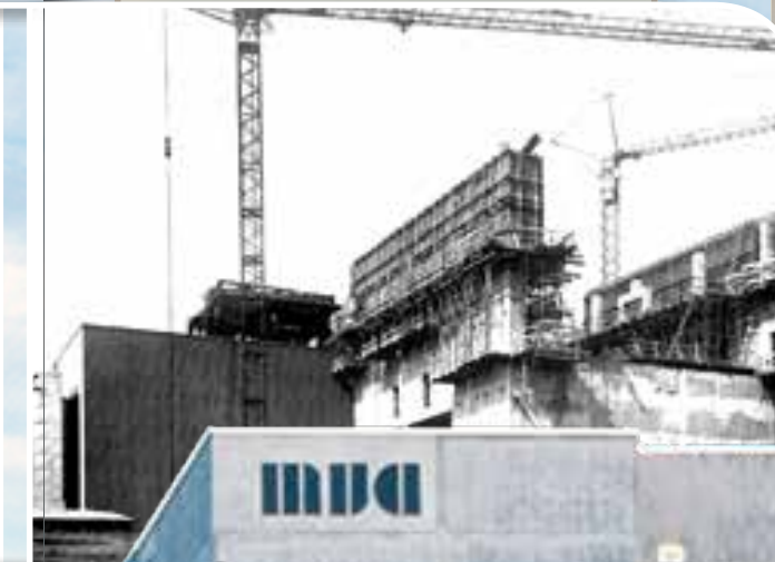
Blick vom Bahn- gleis auf den erweiterten Müllbunker.
