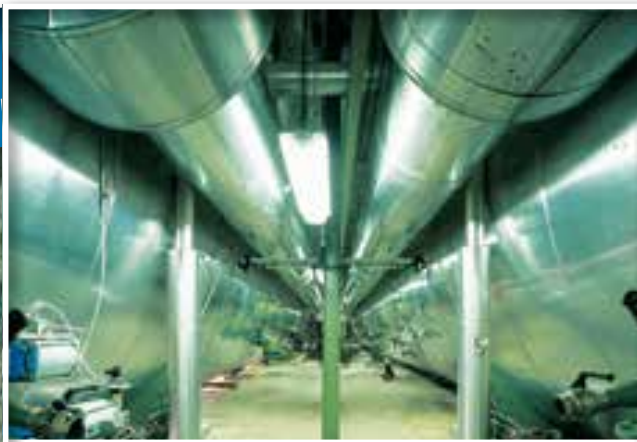
Gärreaktoren in der Vergärungsanlage OA-Süd. Täglich werden hier bis zu 2.600 m³ Biogas erzeugt. Das entspricht der Energie von 1.500 Litern Heizöl.
