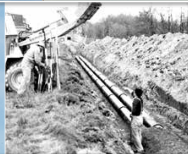
Baustelle Fernwärmenetz: Die verlegten Wanit-Doppelleitungen werden eingesandet.
