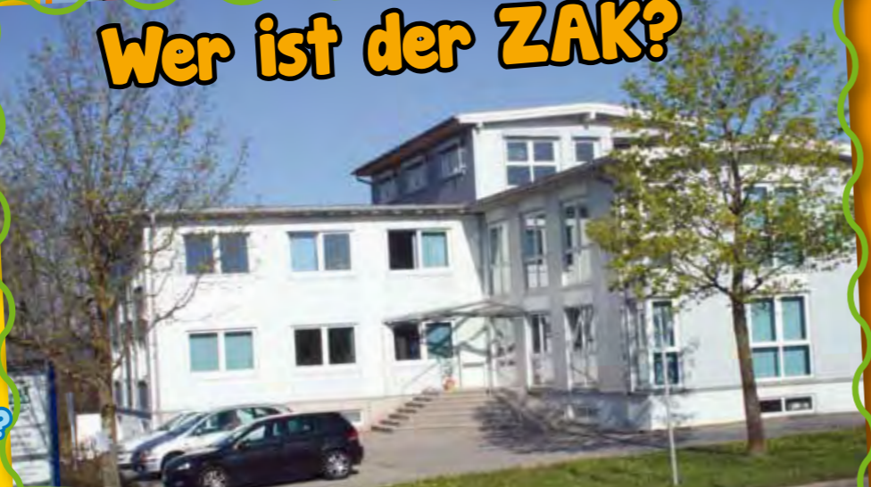
Foto: Verwaltungsgebäude des ZAK in Kempten
