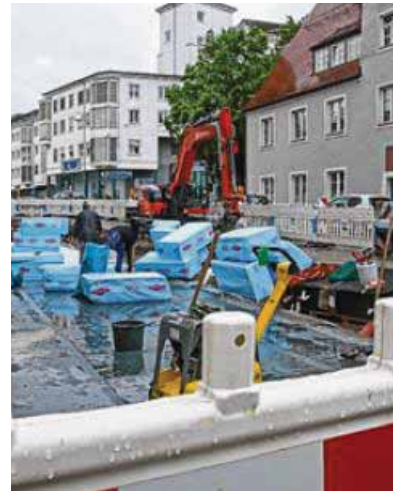
Für die Fernwärmeleitung wird die Kronenstraße komplett gesperrt. Foto: Becker
