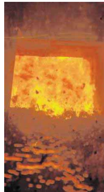
Blick in die Brennkammer des Müllheizkraftwerkes in Kempten. Die Ofenlinie III war wegen des Einbaus der neuen Rauchgasreinigung mehrere Monate außer Betrieb. Archiv-Foto: Ralf Lienert
