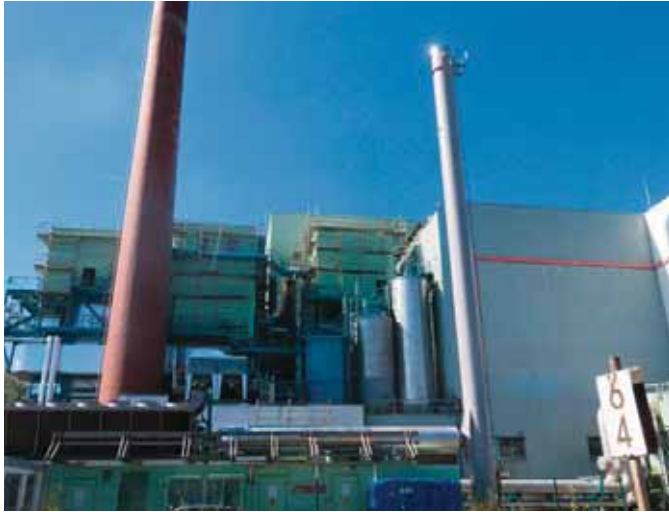
Die neue Rauchgasreinigung am Holzheizkraftwerk des ZAK.
