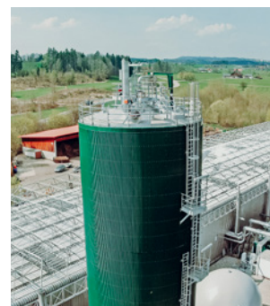
VERGÄRUNGSANLAGE KEMPTEN - SCHLATT
