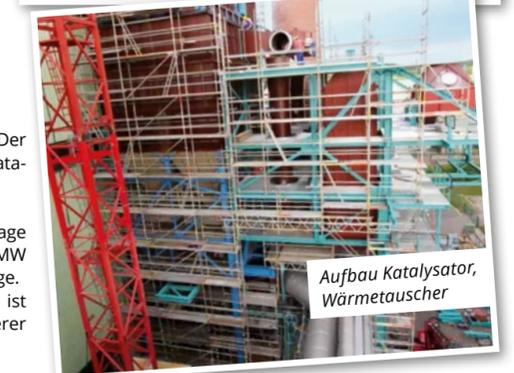
Aufbau Katalysator, Wärmetauscher
